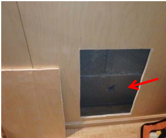
Kuva 69. Väliseinän rakenneavaus, auditorio.
