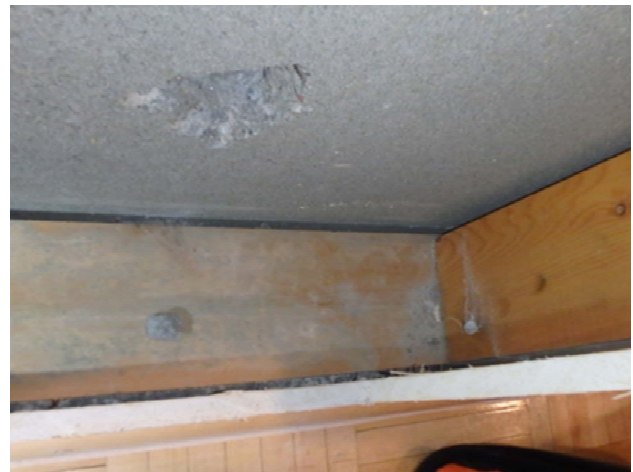
Kuva 70. Harkkorakenteisen väliseinän sisäpuolinen koolaus.
