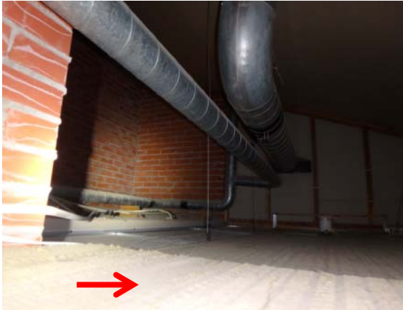
Kuva 83. Alaslaskujen levyt ovat mineraalivillalevyjä.
