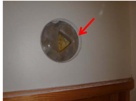
Kuva 48. Ikkunan yläpuolisen puuverhoillun osan rakenneavaus.
