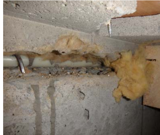
Kuva 36. Seinän yläosassa on valun aikaisia laudoituksia ja mineraalivillaa.
