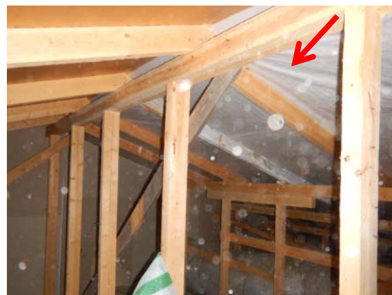
Kuva 80. Osa rakennuksen vesikatteista on uusittu.
