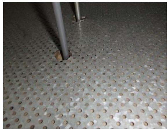
Kuva 88. Tuloilmakanavan seinien ääneneristeenä on mineraalivillaa.
