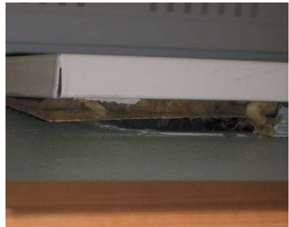
Kuva 86. Rikkinäinen mineraalivillaeriste.
