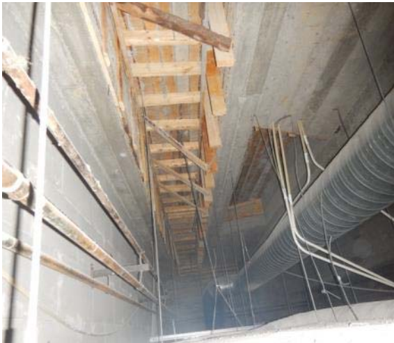
Kuva 23. Auditorion parven alapuolelle on jätetty vanhoja muottilautoja.
