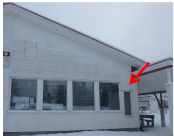
Kuva 46. Ikkunoiden yläpuolella on puuverhoituja ja puurakenteisia ulkoseiniä.
