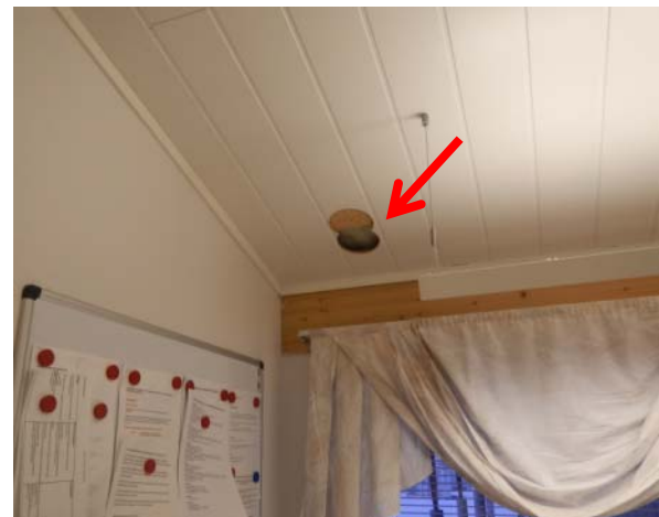
Kuva 74. Rehtorin huoneen sisäkaton rakenneavaus.
