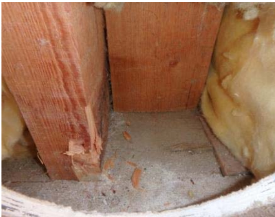
Kuva 43. Rakenneavaus tuulikaapin 119 ulkoseinärakenteen alaosaan.
