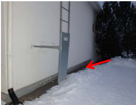
Kuva 49. Auditorion näyttämön yläosan ulkoseinän rakenneavaus US9.
