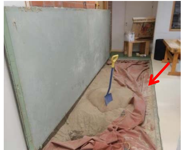
Kuva 14. Teknisen työn luokassa on pituushyppymonttu. Hiekka on kostea, pressussa ja kannessa on näkyvää mikrobikasvustoa.
