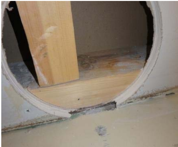
Kuva 67. Väliseinän rakenneavaus, teknisen työn luokka VS2.
