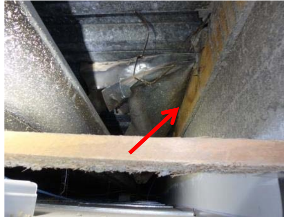
Kuva 26. Vanhoja muottilautoja.
