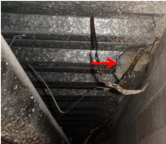
Kuva 27. Mahdollisesti valun aikaisia mineraalivillatilkkeitä.
