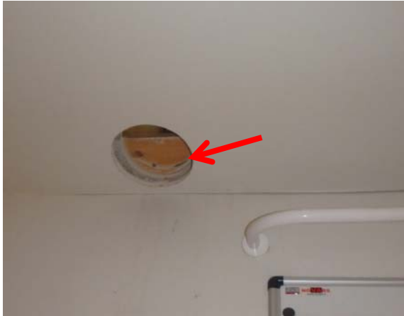
Kuva 75. Rakenneavaus ruokalan vuotojäljen kohdalle.
